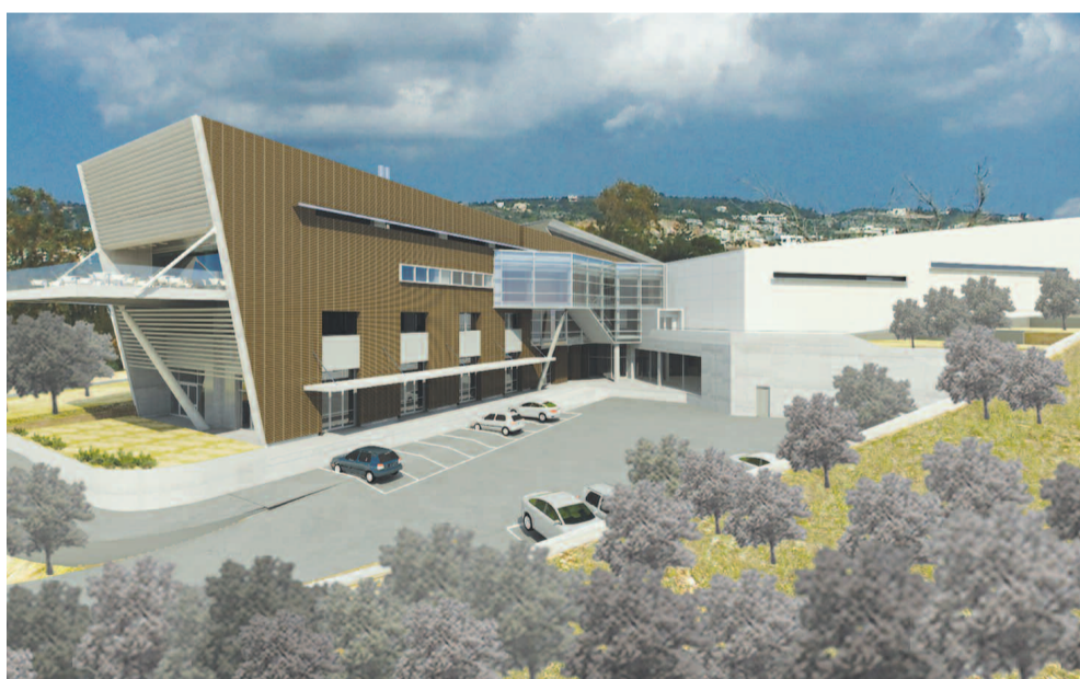
Αρχαιολογικό Μουσείο Χανίων, Χαλέπα. Α' Βραβείο Πανελληνίου Αρχιτεκτονικού Διαγωνισμού. Αρχιτέκτων: Θεοφάνης Μπομποτής. Μελέτη 2005 - 2008. Βρίσκεται στο στάδιο της κατασκευής.
