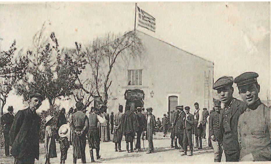
Ξεχωριστή σημασία στην ιστορία του Κήπου αποτελεί το γεγονός ότι στη βορειοδυτική του πλευρά βρισκόταν κάποτε το κτήριο της Κρητικής Βουλής (φωτ. αρχείο Ζ. Σημανδράκη). Το συγκεκριμένο κτίσμα κατέρρευσε το 1911 και αργότερα κατεδαφίστηκε.
