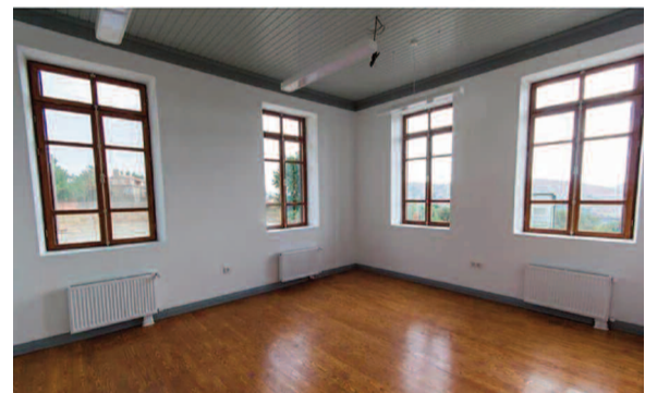
Οι σχολικές αίθουσες εγκαταλελειμμένες για χρόνια (φωτ. πάνω) αποκαταστάθηκαν πλήρως (φωτ. κάτω).
