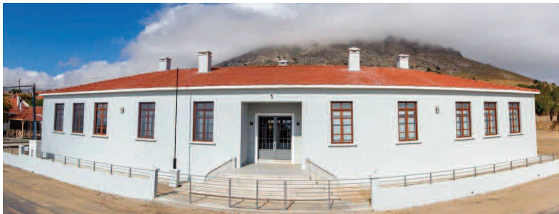
Το σχολικό συγκρότημα όταν βρισκόταν στη διαδικασία της ανακατασκευής (φωτ. αριστερά) και όπως είναι σήμερα (φωτ. πάνω).
