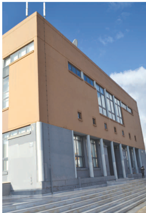
Μια εντυπωσιακή σύγχρονη εγκατάσταση.
