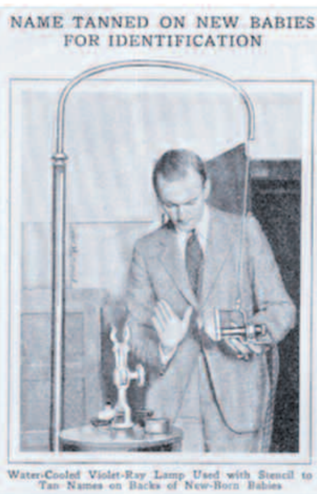
Πατέντα του 1930: με τη χρήση λάμπας υπεριώδους φωτός και ειδικού στυλό σχηματιζόταν ανεξίτηλα στην πλάτη του νεογέννητου το όνομά του, μετά από επαναλαμβανόμενα κρούσματα απόδοσης μωρών σε λάθος γονείς. Το όνομα έφευγε μόνο του μετά από 6 περίπου μήνες.
