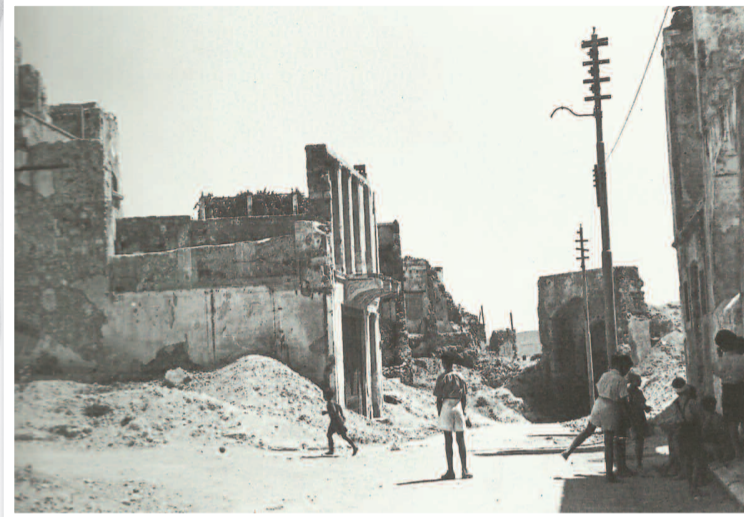
Ισοπεδωμένα κτήρια στην οδό Κανεβάρο.
